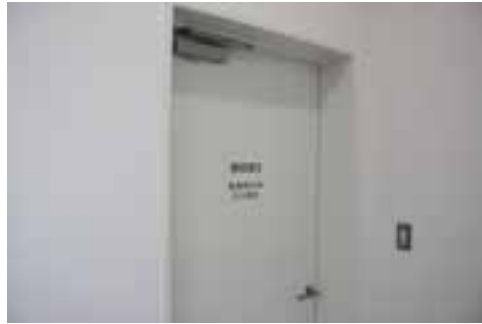
非常階段の検証
