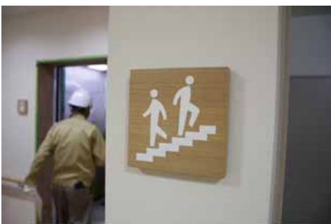
階段案内板の検証
