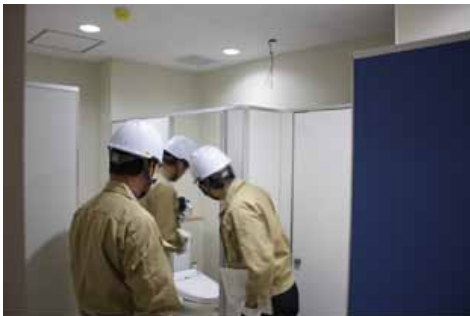
トイレ内の検証
