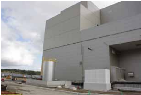
むき出しの路面で作業中なことを確認出来ます
