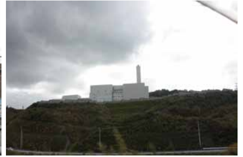
山の中腹部に新ごみ処理施設を確認
